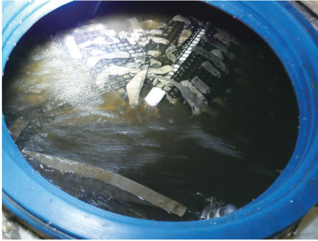
〈그림 3.14〉 폭기조 내에 설치된 담체
