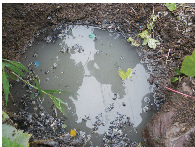
〈그림 3.10〉 상단부가 지면보다 낮게 설치된 유량 조정조
